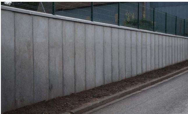
Photo d'un mur de soutènement sur voirie.
